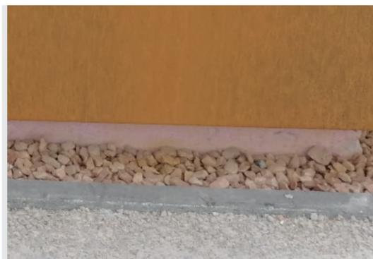
Beispiel für die Wasserführung der Niederschläge am Boden bei wetterfestem Stahl: Über ein schmales Bett aus Stein wird das Wasser abgeleitet (DAS UNENDLICH ENTWURF 2)
